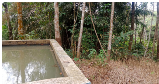
Gambar 28. Tempat Penampungan Air
